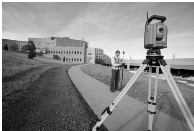
Рисунок 2. Производство геодезических работ
