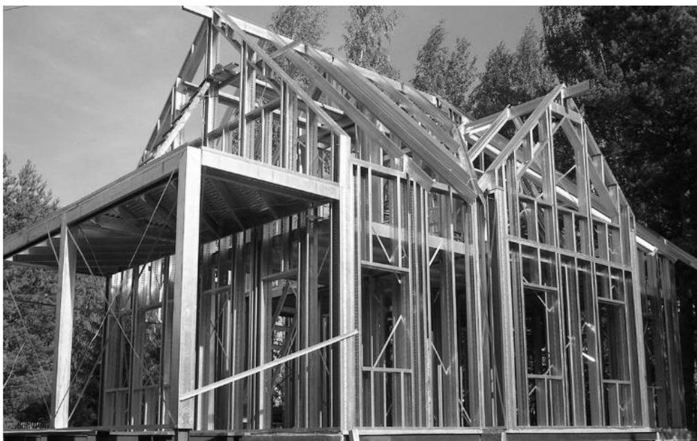
*Рисунок 2. Металлический каркасный дом*
