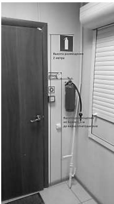
**Рисунок 1. Размещение огнетушителя**
