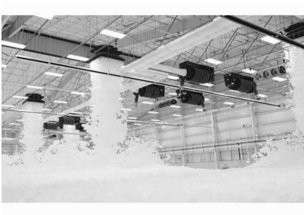
Рисунок 1. Работа системы автоматического пожаротушения
