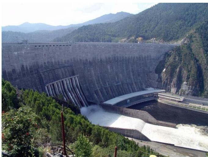
**Рисунок 1. Эксплуатационный водосброс Саяно-Шушенской ГЭС в действии (2010)**
