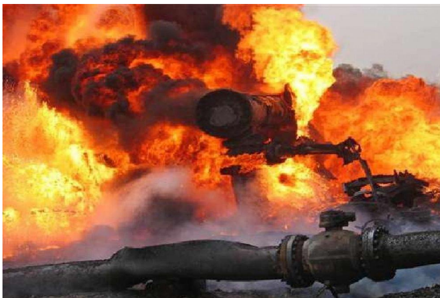
Рисунок 1. Пожар на магистральном нефтепроводе
