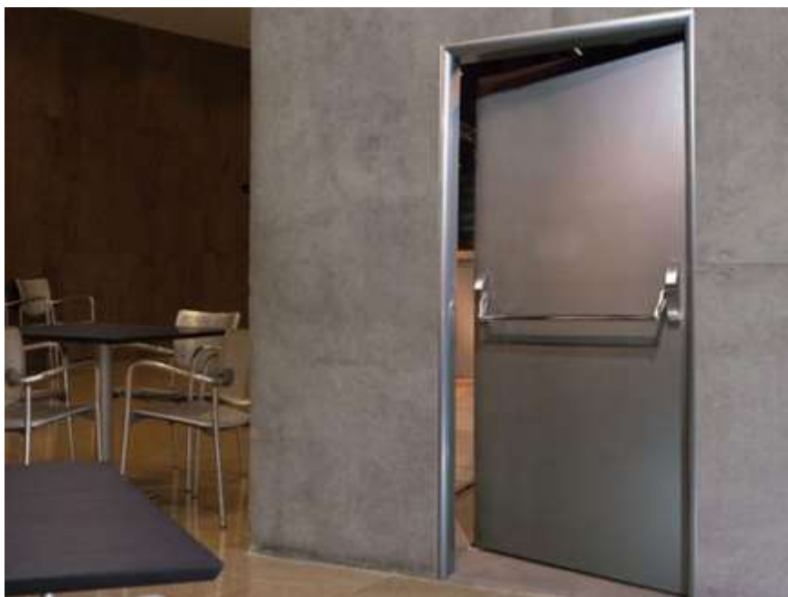
Рисунок 1. Противопожарная дверь
