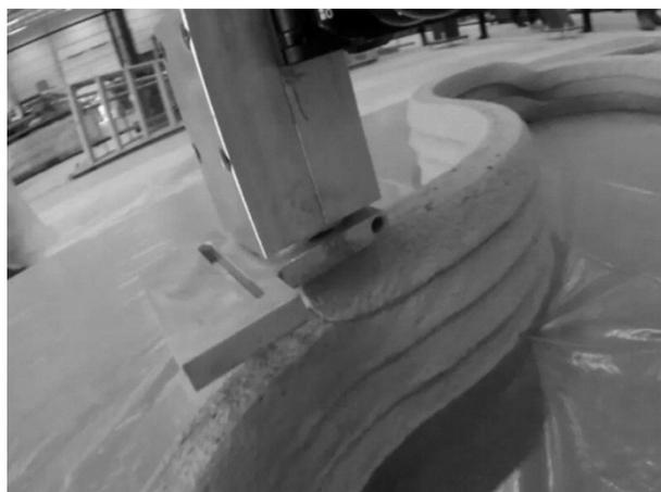
**Рисунок 2. 3D-бетонный принтер в действии. Бетон без спада оставляет сопло в виде относительно жесткой непрерывной нити накала**
