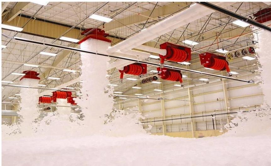
**Рисунок 2. Работа системы автоматического пожаротушения**
