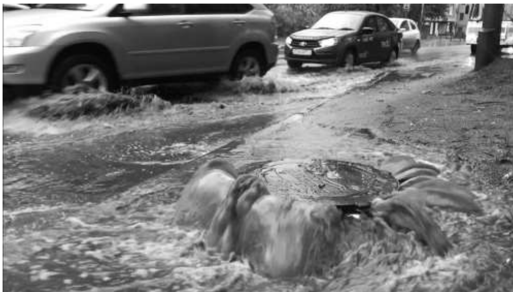
Рисунок 1. Затопленный участок ливневой канализации г. Томска [2]
