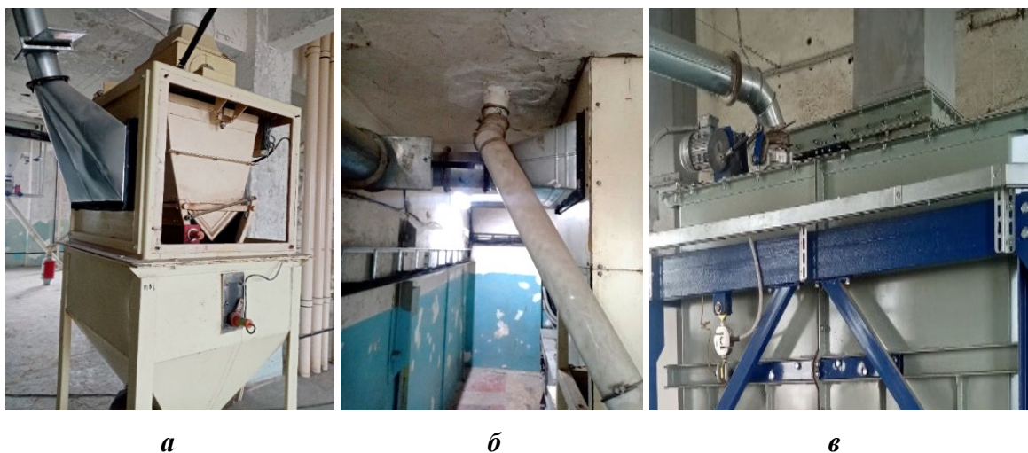
Рисунок 3. Подключение аспирационной системы прямое (а, б) и через клапан (в)
