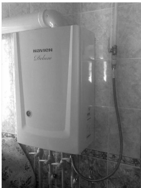
**Рисунок 1. Настенный двухконтурный газовый котел «Навьен» с закрытой камерой сгорания, с коаксиальным дымоходом**
