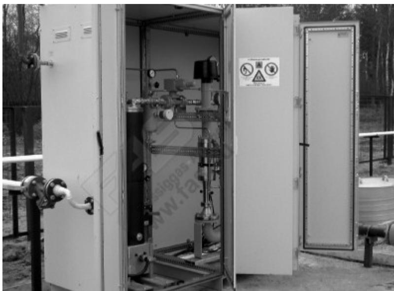
**Рисунок 3. Комбинированная смесительная установка FAS 4000, установленная в коттеджном поселке (Московская область)**
