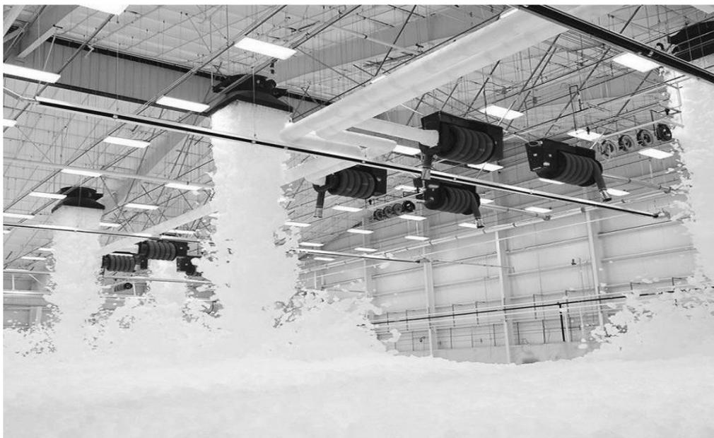
***Рисунок 1. Работа системы автоматического пожаротушения.***
