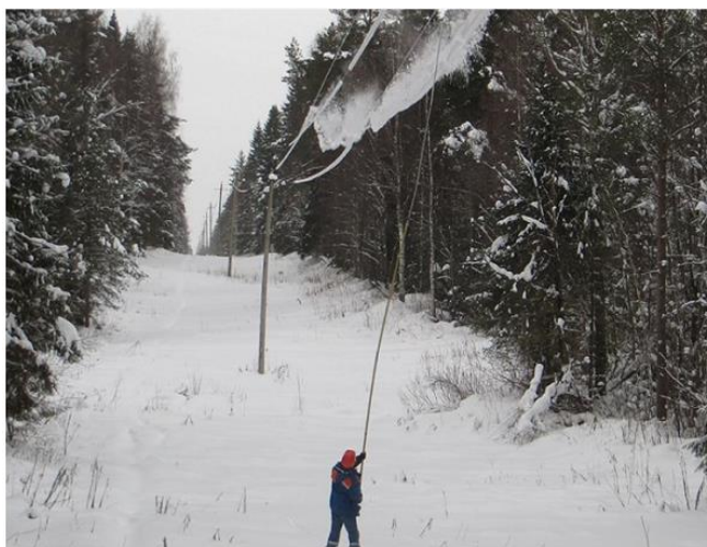
Рисунок 1. Графическое представление механического метода борьбы против гололеда
