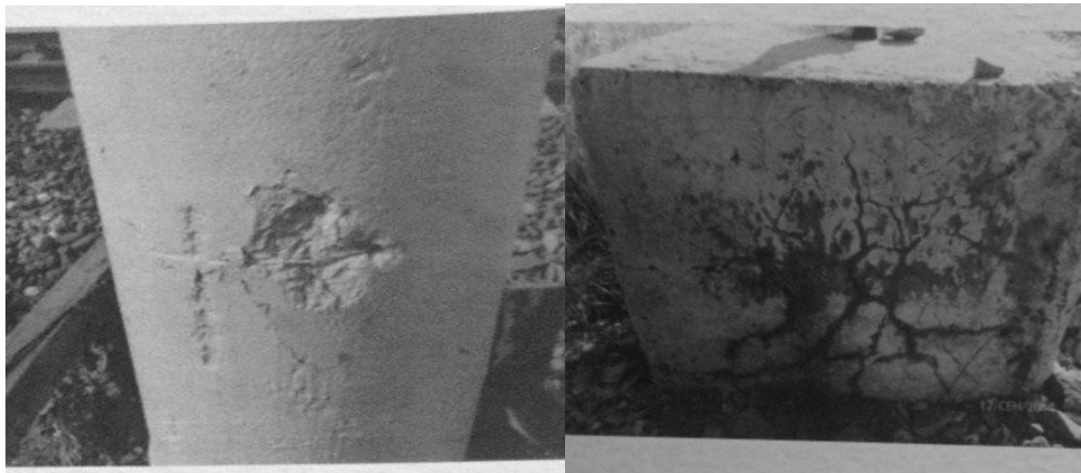
Рисунок 2. Внешний вид дефектных опор
