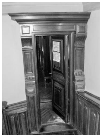
Рисунок 13. М. Месмахер. Детали отделки дома В.Ф. Гагариной на Большой Морской улице в Санкт-Петербурге
