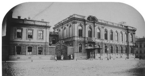
Рисунок 5. Дом графа П.С. Строганова на Сергиевской улице в Санкт-Петербурге. До перестройки М. Месмахера.
