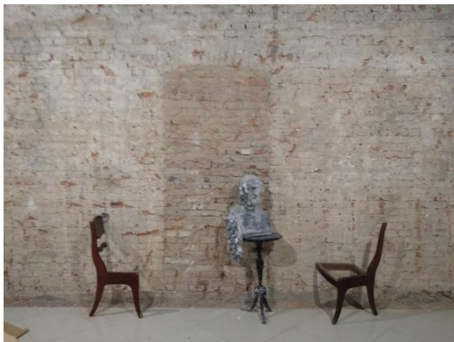
Рисунок 6. Фото кирпичной стены с удаленной штукатуркой, на которой виден заложенный дверной проем в сторону Строгановского дворца. 2022 год
