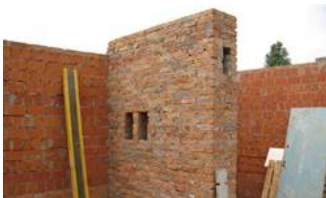
***Рисунок 1. Вентиляционный канал из кирпича***
