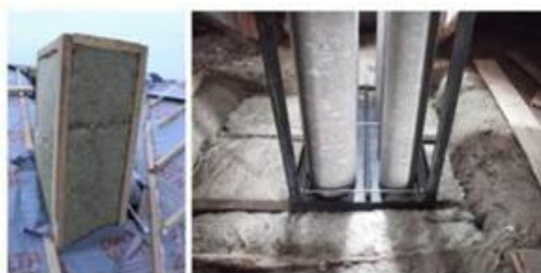
***Рисунок 3. Вентиляционный канал из асбестоцемента***
