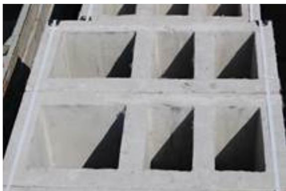
***Рисунок 5. Вентиляционный канал из блоков фибропенобетона***
