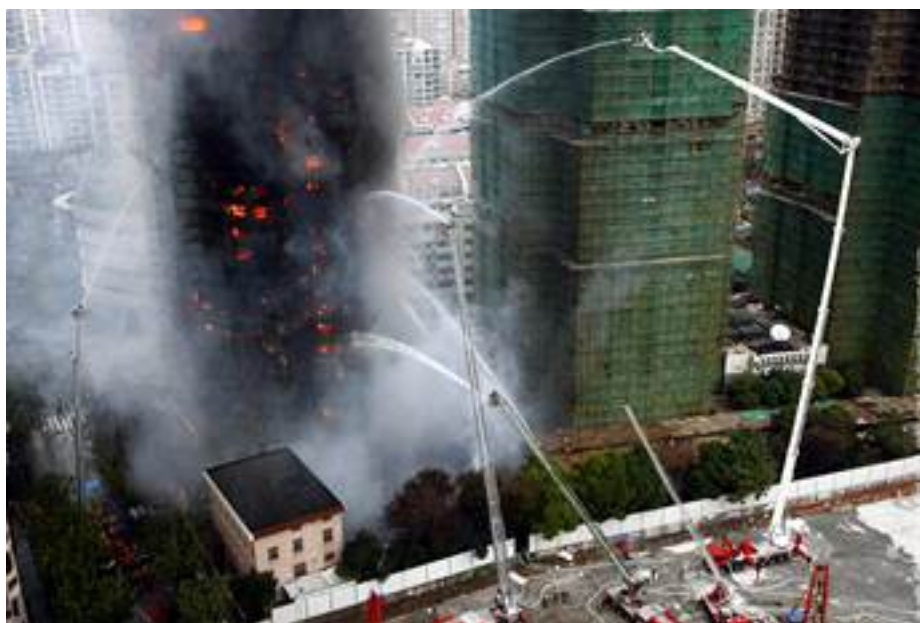
Рисунок 2. Пожар в строящемся здании в Шанхае (Китай)
