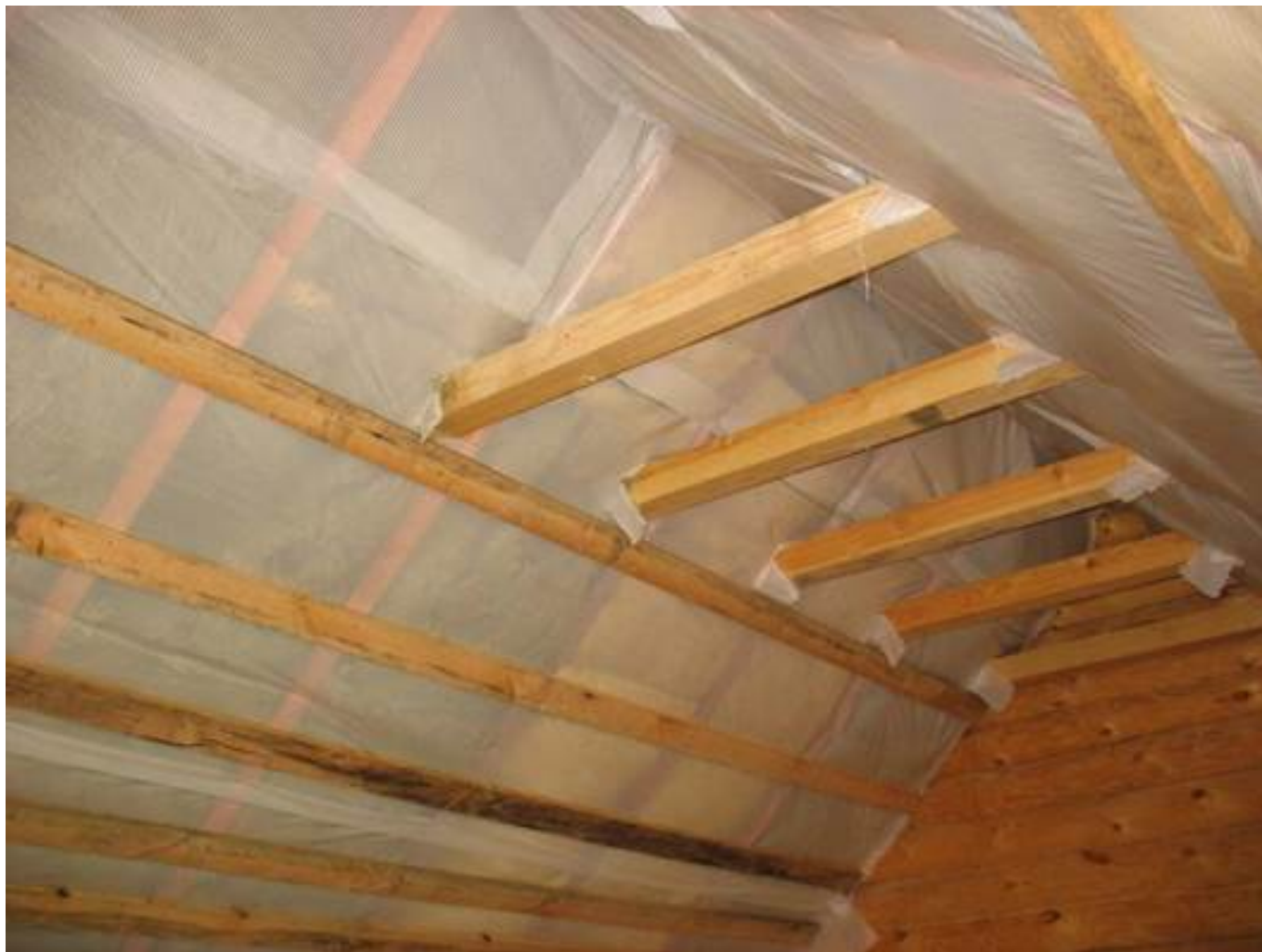
Рисункок 3. Утепление крыши
