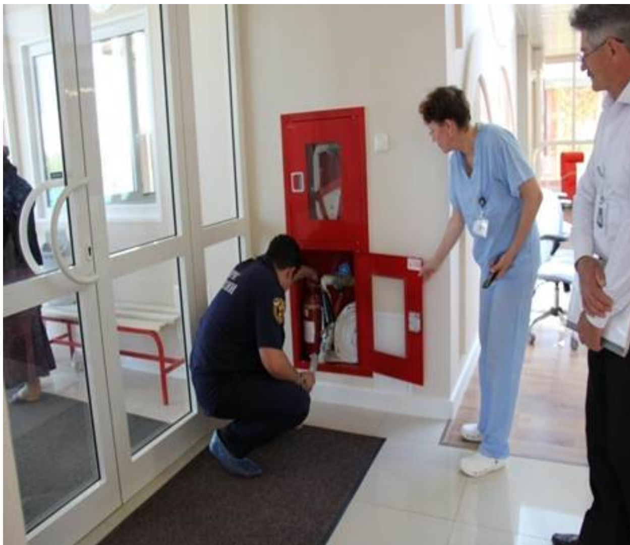
Рисунок 1. Пример размещения огнетушителя в медицинских учреждениях
