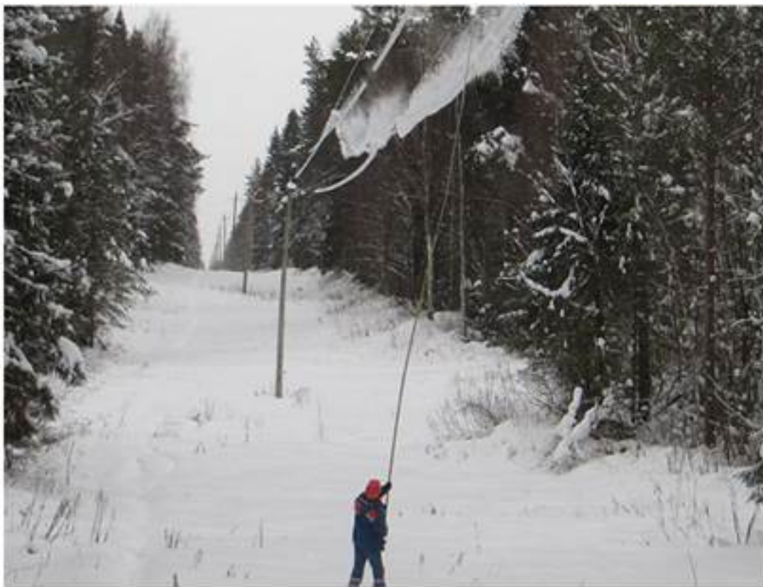
Рисунок 1. Графическое представление механического метода борьбы против гололеда
