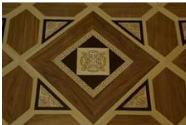
Рисунок 5. Фрагмент паркета Большой гостиной С.В. Строгановой после завершения гравировки
