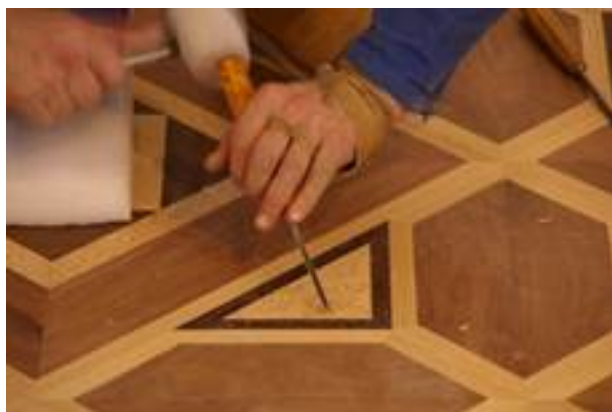
Рисунок 2. Процесс вырезания желобков на паркете в Большой гостиной С.В. Строгановой
