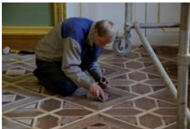
Рисунок 3. Заполнение углублений специальной пастой
