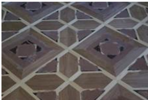
Рисунок 4. Фрагмент паркета после затирки углублений пастой
