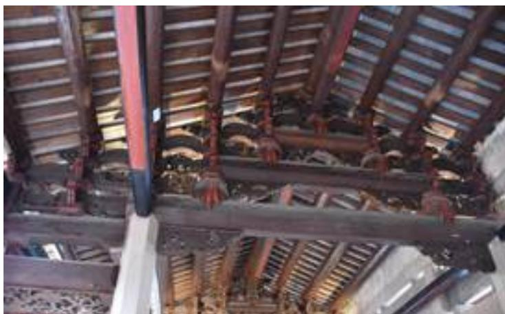
**Рисунок 1. Подъемно-балочная конструкция**
