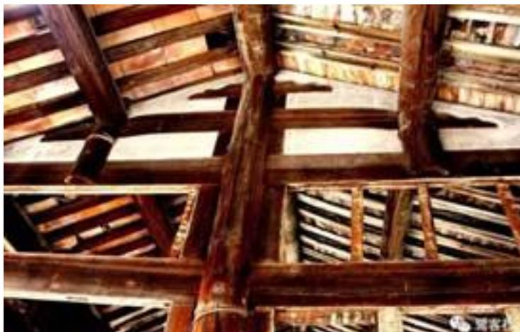
*Рисунок 2. Проходная конструкция*
