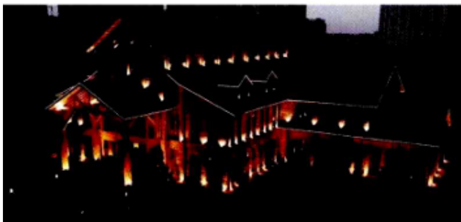
Рисунок 5. Деревянный каркасный клубный дом в городе Дацзин.
