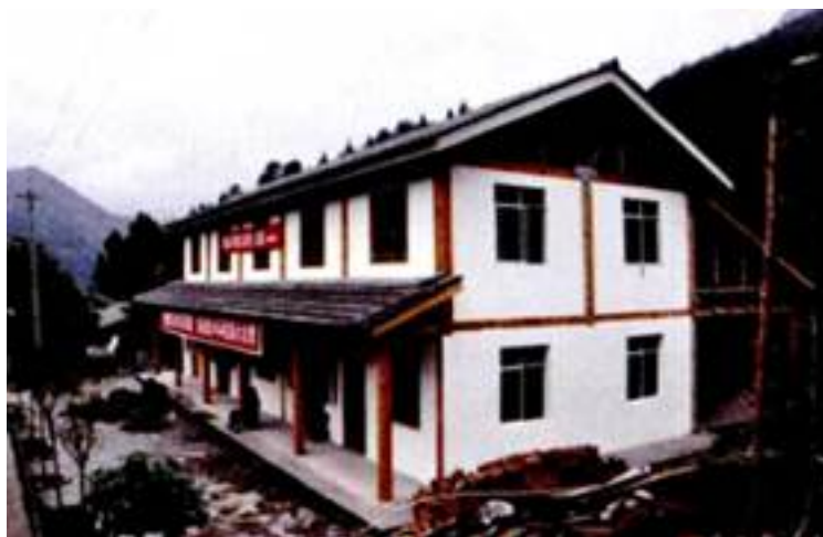
Рисунок 2. Современный деревянный дом
