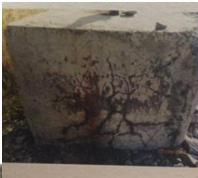
**Рисунок 2. Внешний вид дефектных опор**
