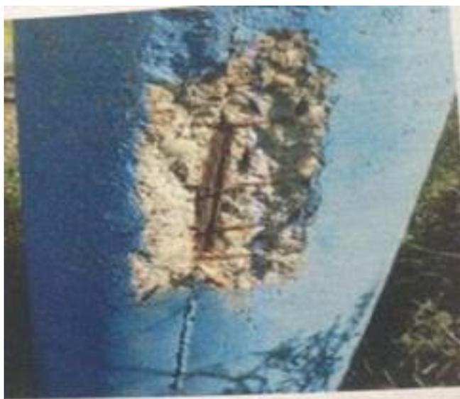
***Рисунок 1. Внешний вид остродефектной опоры***
