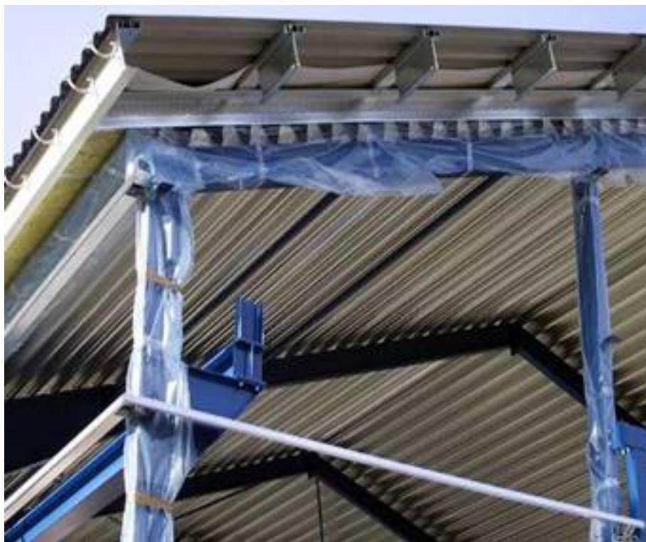
Рисунок 1. Двухслойное утепленное плоское покрытие на основе профилированного листа промышленного здания
