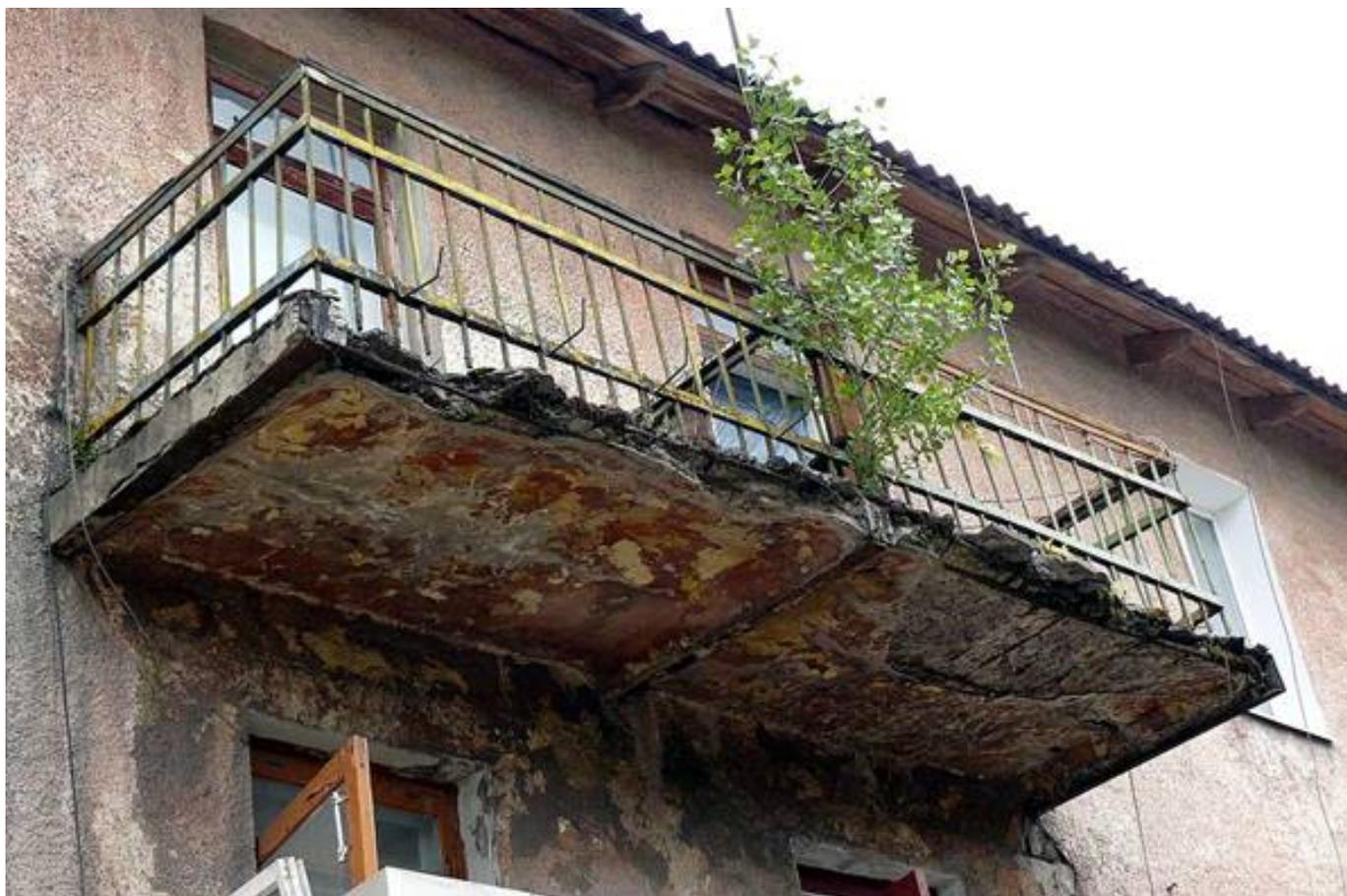
***Рисунок 1. Обрушение балконной плиты***
