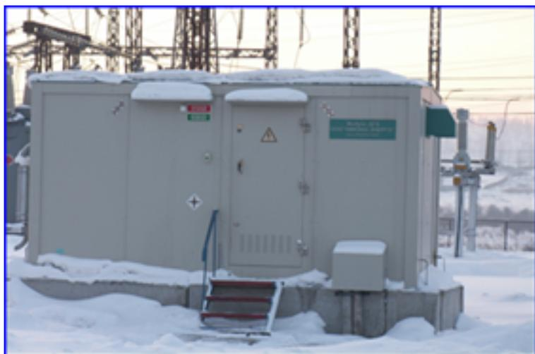
*Рисунок 6. Модульный блок ДГА*
