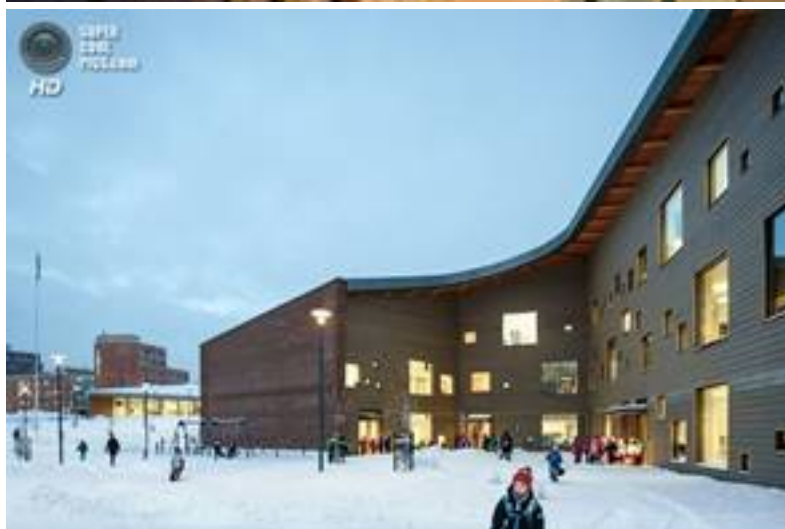
Рис.3. Вид на фасад со двора
