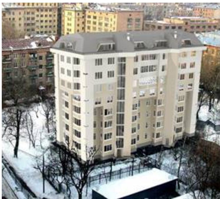
Рисунок 4. Реконструкция жилого дома в Москве на ул. Мишина, 32
