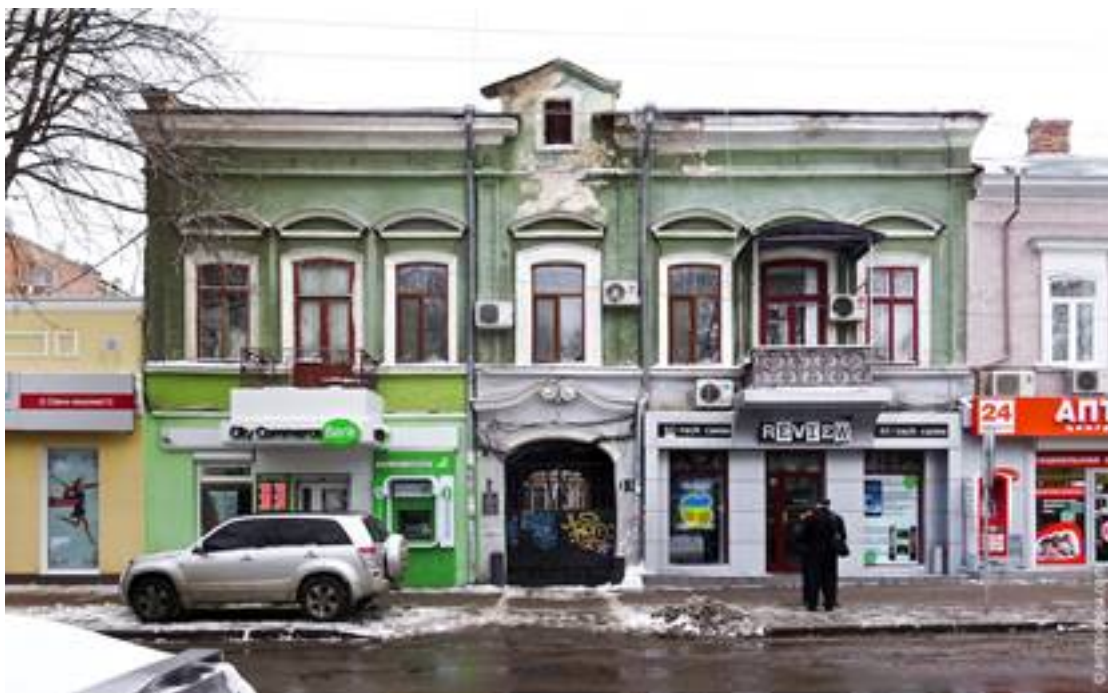
Рисунок. 4 Фактическое состояние фасада здания, просп. Александровский, 3 (дом Мерца), Украина
