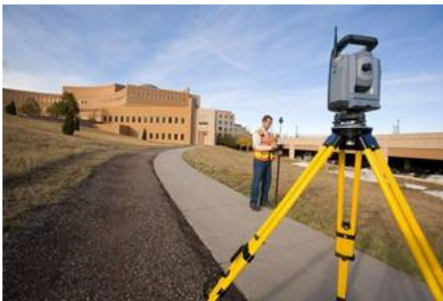
Рисунок 2. Производство геодезических работ
