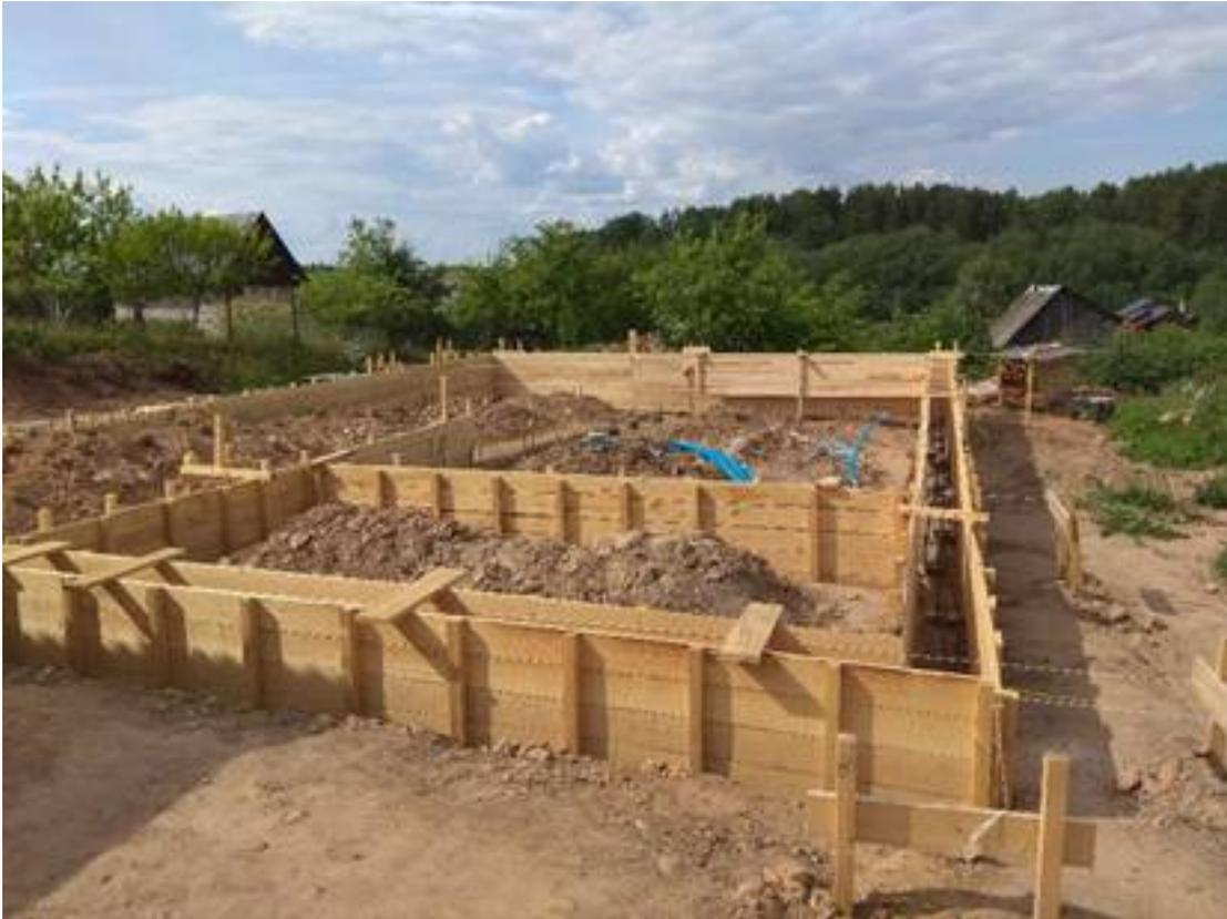
*Рисунок 2. Деревянная опалубка*
