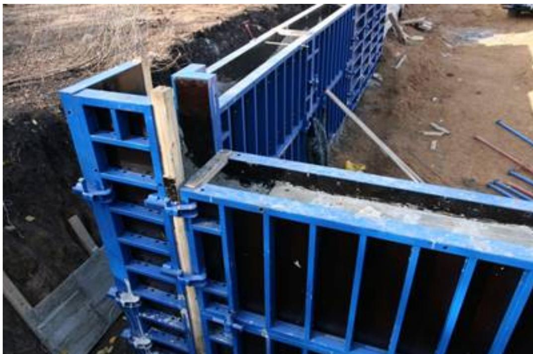
*Рисунок 3. Металлическая опалубка*
