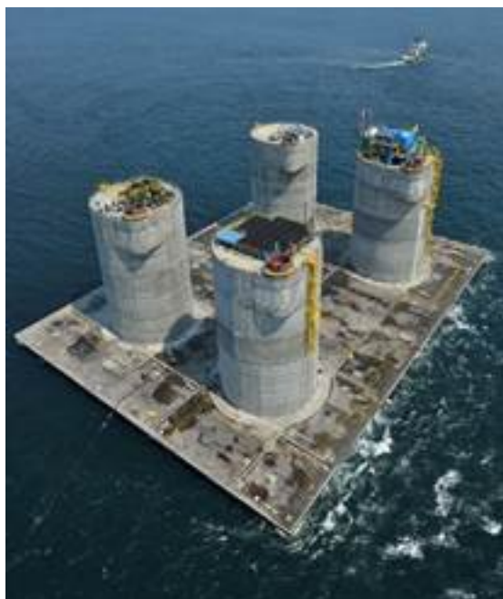
Рисунок 2 . Бетонный ледозащитный пояс платформы «Беркут»
