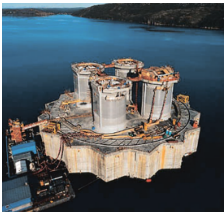
Рисунок 5 . Опорная часть платформы «Hibernia»
