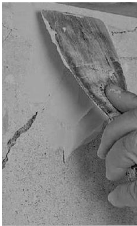
Рисунок 3. Устройство гипсовых маяков
